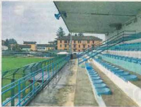
Lo stadio comunale: dopo l'illuminazione, presto gli altri lavori
