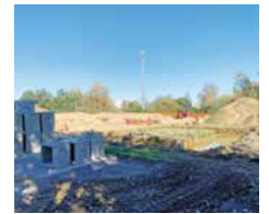
La piazzola ecologica è in fase di costruzione
